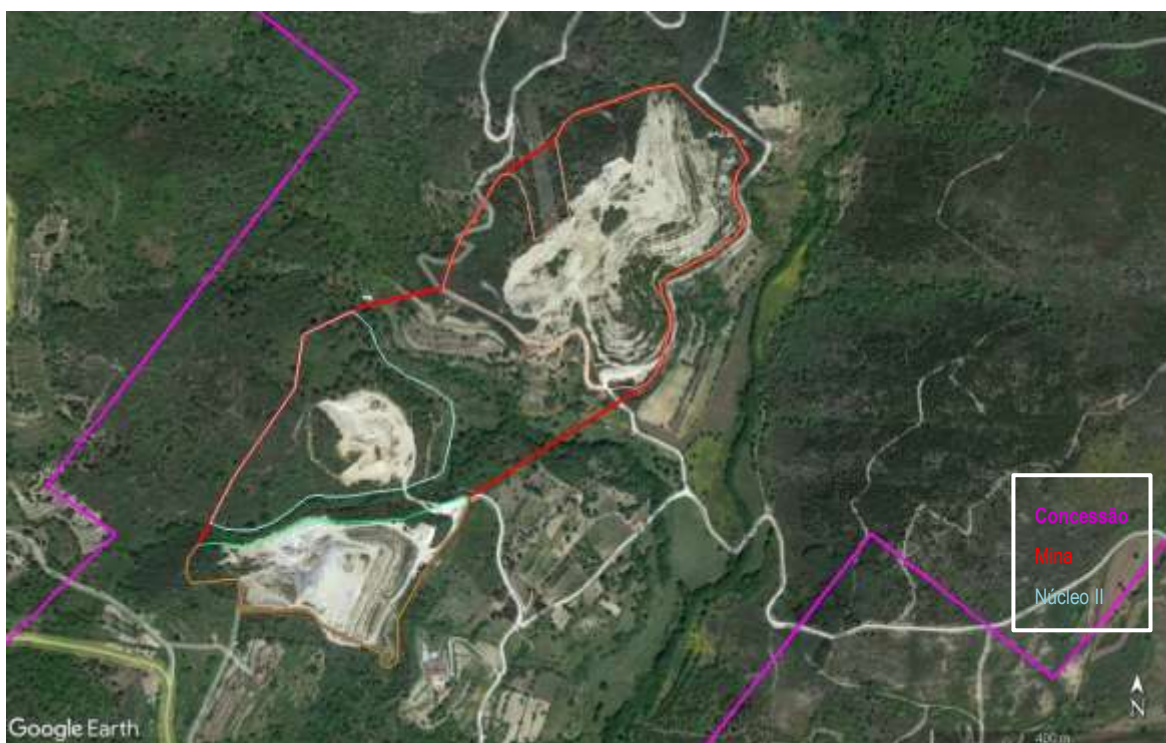
Figura III.27 – Fotografia aérea da mina.
